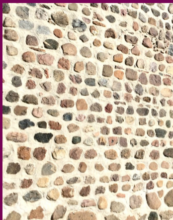
St. Georgskirche, Südwand
