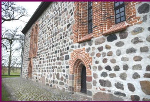
St. Georgskirche, Südwand
