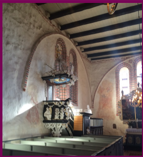
St. Georgskirche, Blick nach Nordosten
