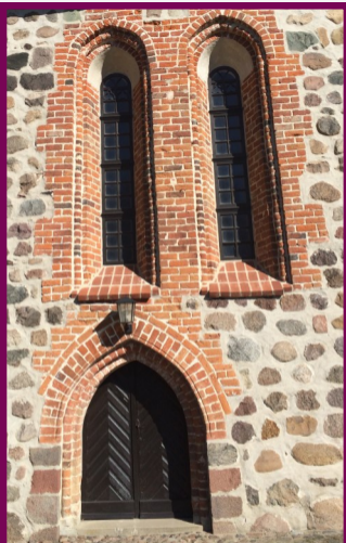
St. Georgskirche, Südportal
