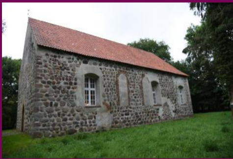
St. Katharinenkirche, Südseite
