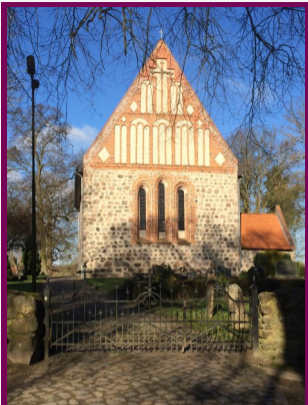
St. Georgskirche, Ostseite
