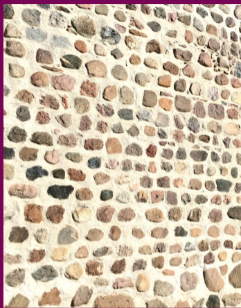
St. Georgskirche, Südwand
