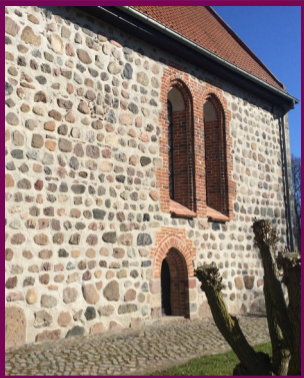
St. Georgskirche, Südwand
