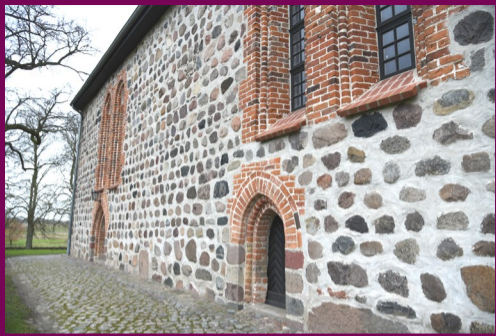
St. Georgskirche, Südwand
