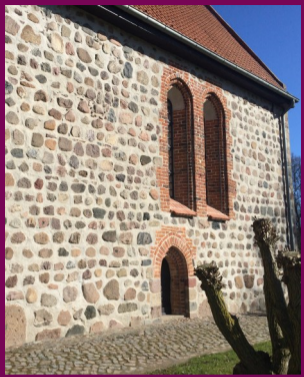
St. Georgskirche, Südwand
