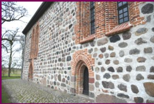
St. Georgskirche, Südwand
