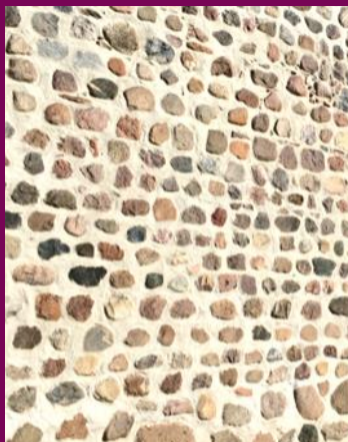
St. Georgskirche, Südwand
