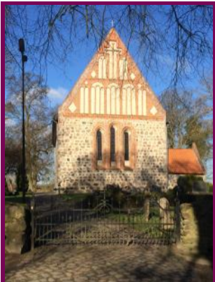
St. Georgskirche, Ostseite
