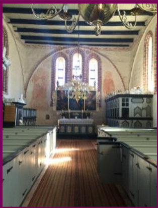
St. Georgskirche, Blick nach Osten
